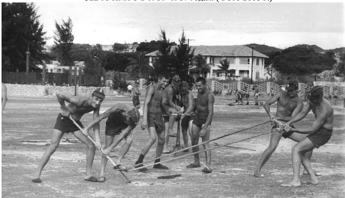
Уборка битума личным составом эскадры на будущем строевом плацу. Фото 1984 г.
